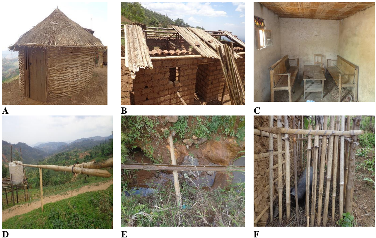
Figure 11 : (A) & (B) bambous en construction, (C) bambous en meuble et en plafond, (D)& (E) bambous utilisés pour arroser un champ, (F) bambous en construction d'enclos
