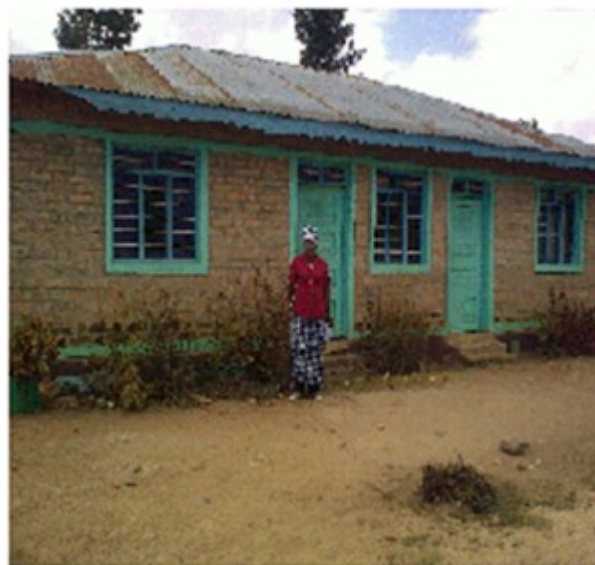
Un éleveur devant sa maison rénovée grâce aux revenus provenant de la production laitière de son bétail
