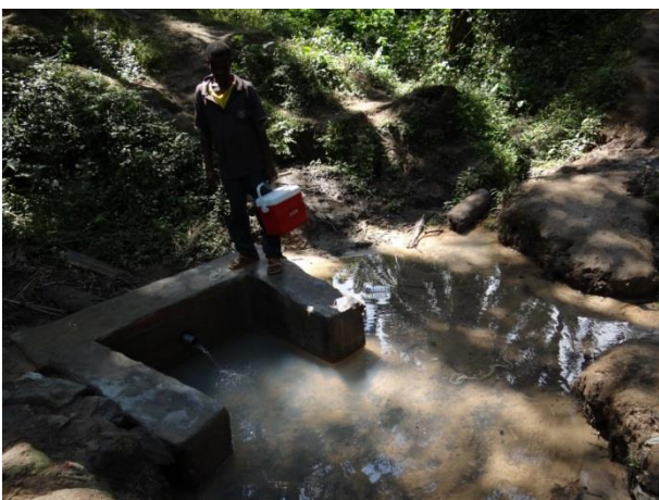
Source aménagée « rusengo » inondée
