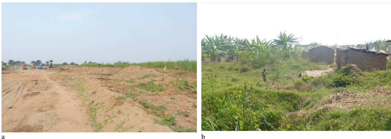
Fig. 19A-B: Ouverture d'une route vers le lieu d'extraction du sable et nouvelles habitations de fortune, champs et cultures dans la zone d'étude
