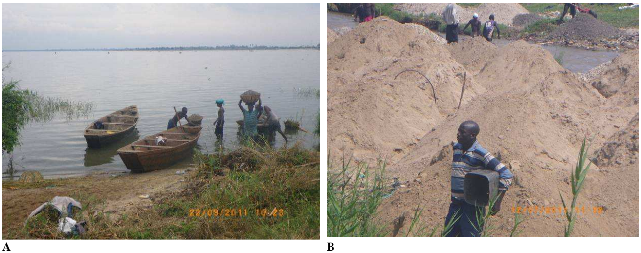
Fig. : Extraction des matériaux de construction : A: Pirogues déchargeant le sable en bordure du lac; B: Un site du sable en exploitation dans l'embouchure de la Ntahangwa
