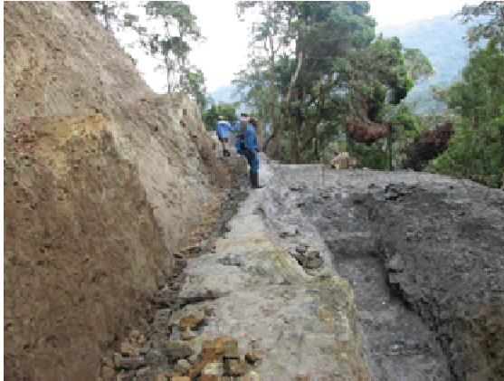
Planche 17a. Canal de captage d'eau dans la forêt en vue d'alimenter le lac artificiel de Ruhondo et ses installations hydroélectriques
