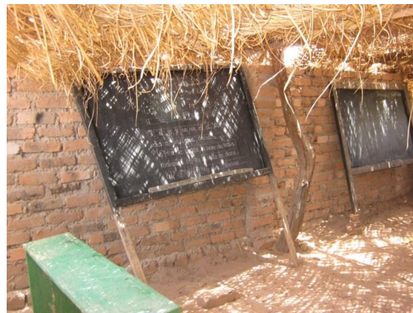
Photo 3 – Tchad 2 : Salle de classe construite par APROFIKAM avec l'argent issu de la vente de Vitellaria paradoxa
