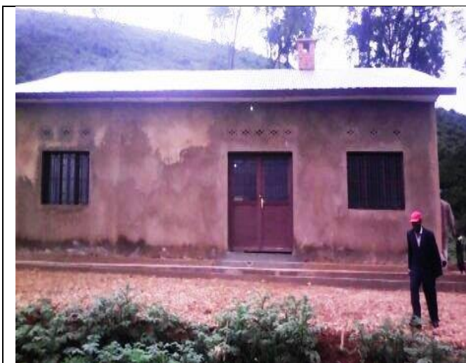
Au dessus, bâtiment abritant les 2 Directions de l'OBPE de Gitega et le poste de patrouille de Nderama au PNK en bas (dessous)
