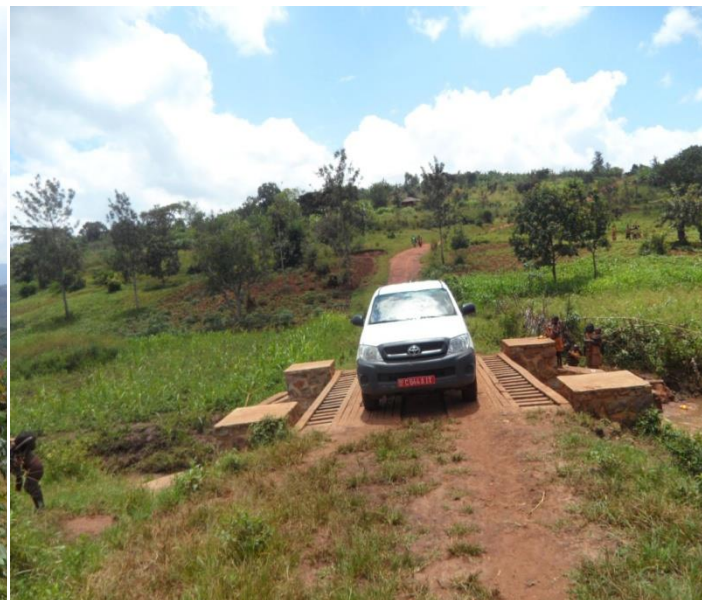
Ponceau aménagé dans le parc de la Ruvubu, rive droite 2rivière séparant les communes Buhinyuza et Mwakiro
