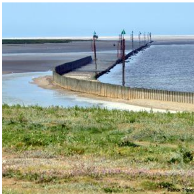
Digue submersible au sud de l'estuaire de la Somme
