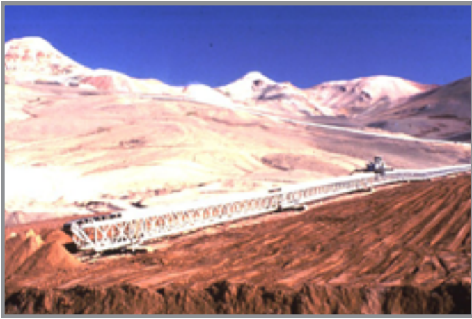
Méthode d'élimination des résidus de mine secs, Mine La Coipa, Chili PHOTO: Tailings.info
