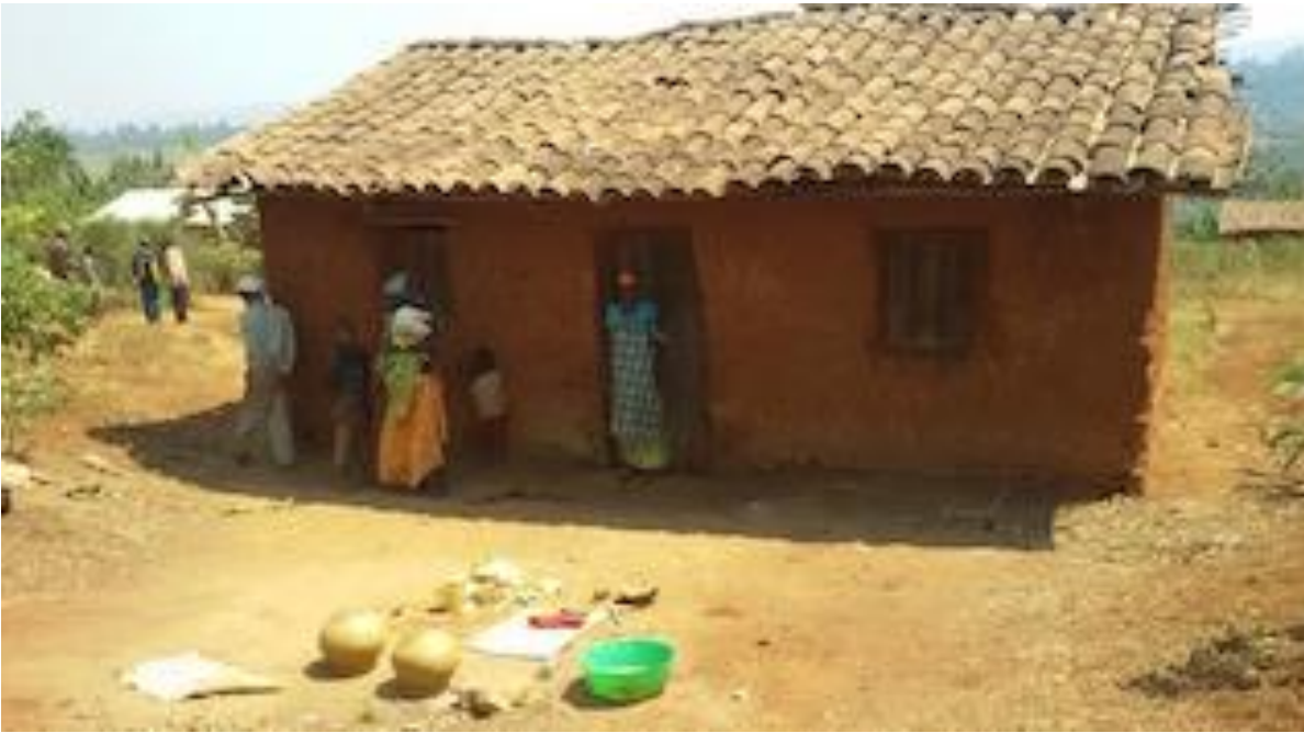
Photo n°1 : Aspect des maisons du village de Mbizi
