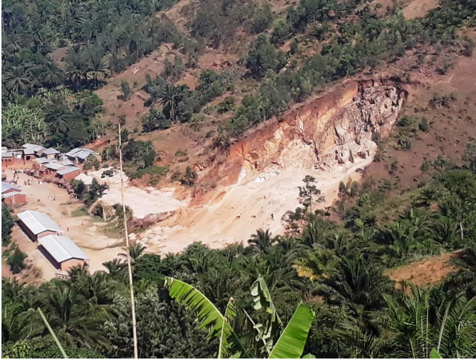
Photo 7. Carrière de Benga en amont de RN1. En fonction de la technique de traitement, il pourrait entraîner la perte des infrastructures (Maisons d'habitation, écoles) et quelques cultures & terres des privées)
