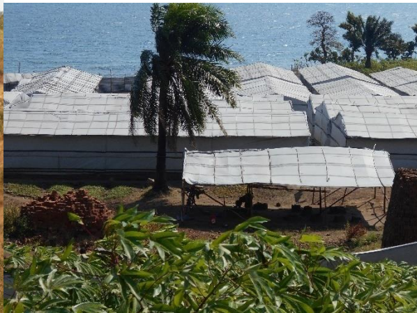
Maisons construites par l'OIM aux sinistrés des glissements de terrain en commune MUHUTA
