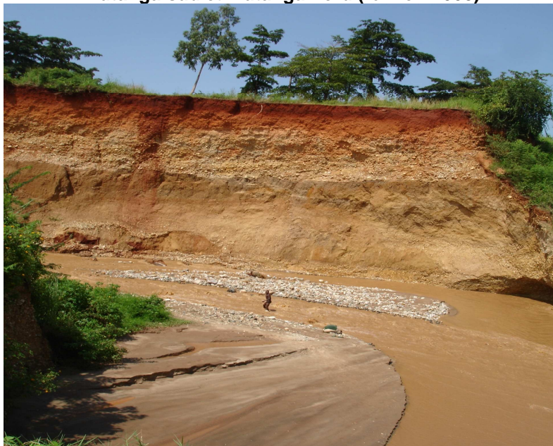
Photo.n°14 : L'éboulement des berges dans la vallée de la Ntawangwa entre Mutanga-sud et Mutanga-nord (février 2008)
