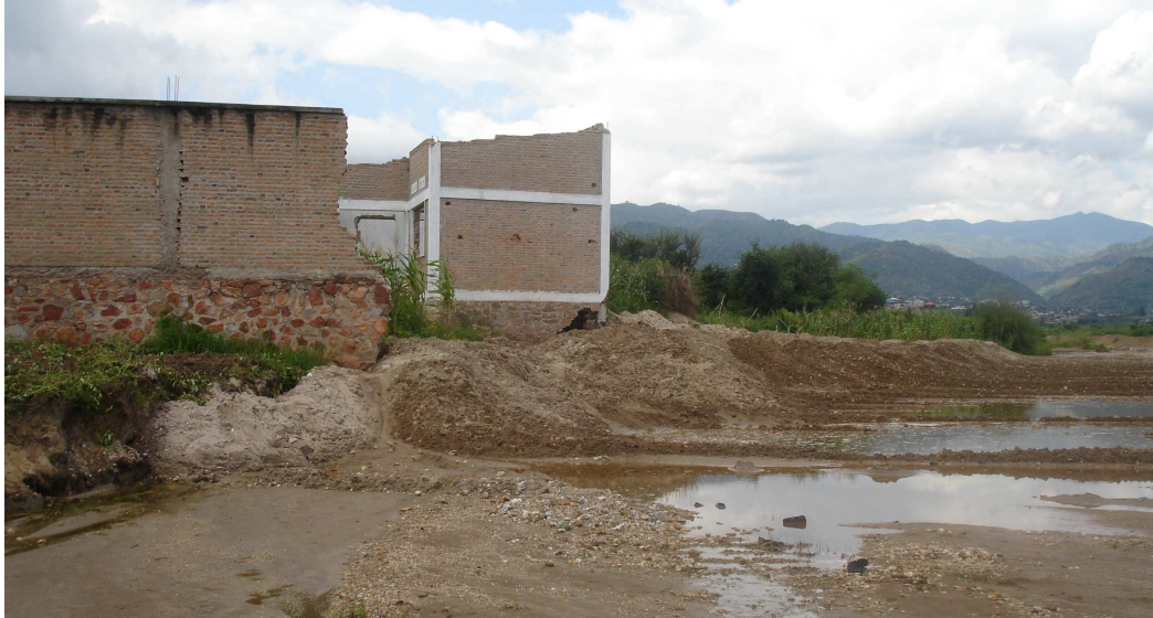
Photo. n°15 : Destructions des maisons riveraines par la Ntakangwa (février 2008)
