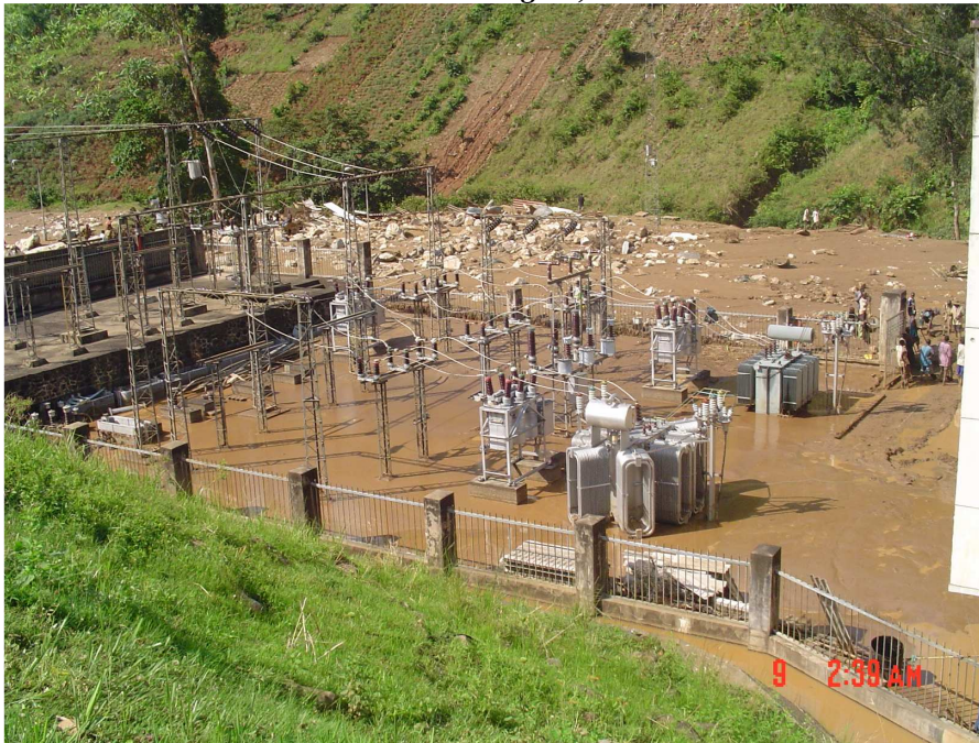
Photo n° 7 : Poste de Mugere, décembre 2007.
