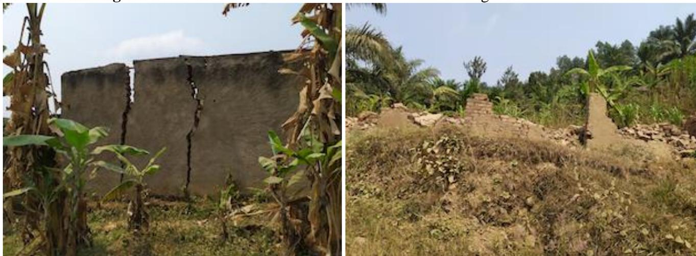
**Images 6 et 7 :** Fissures et destructions des champs suite au glissement de terrain
