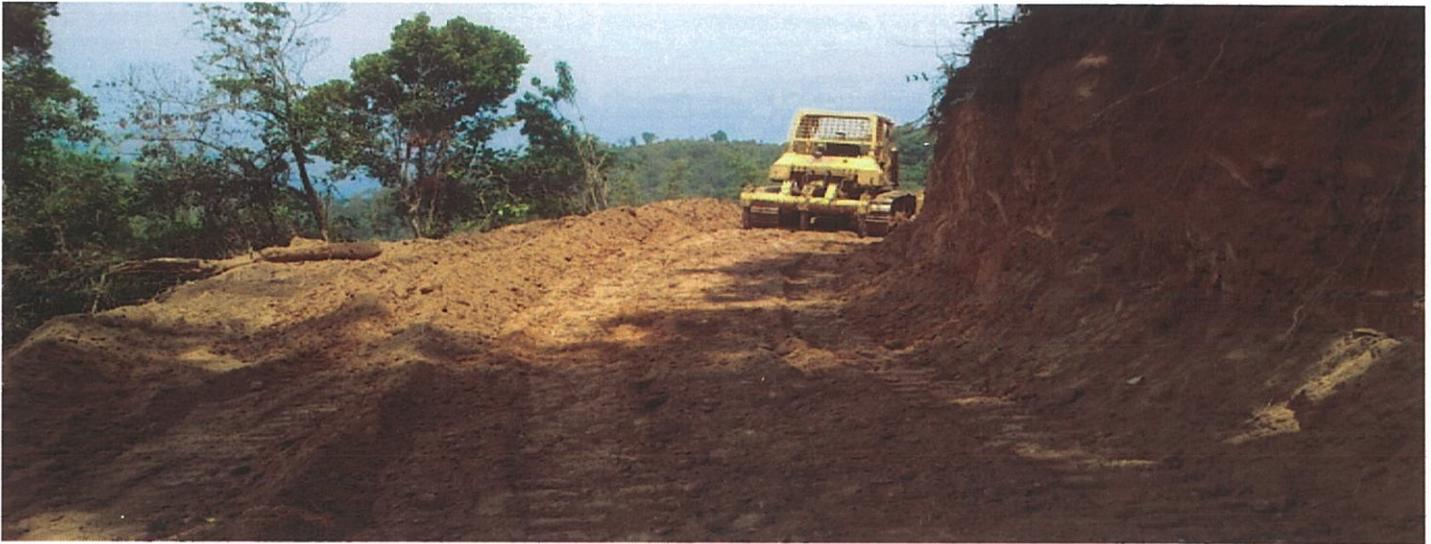
Figure 12: vue des engins occupés au traçage de la piste menant vers le barrage.
