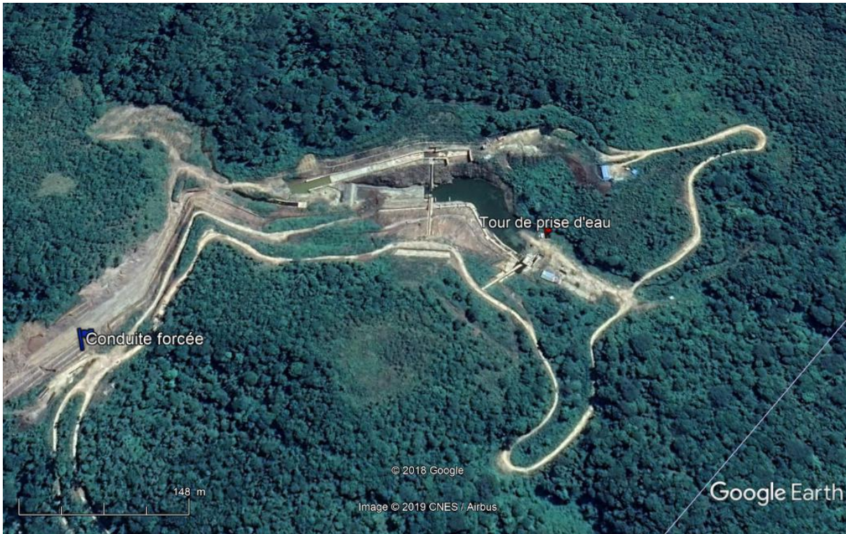
Figure 1: Vue satellitaire du parcours vers le site du barrage
