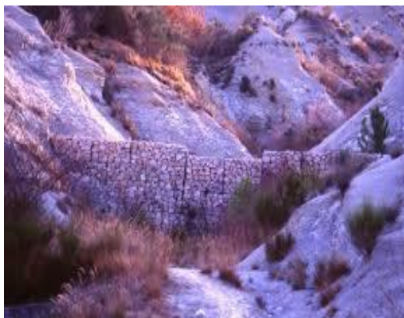
Figure 47 : Ouvrage en gabions posé dans le ravin (source : unt.unice.fr )
