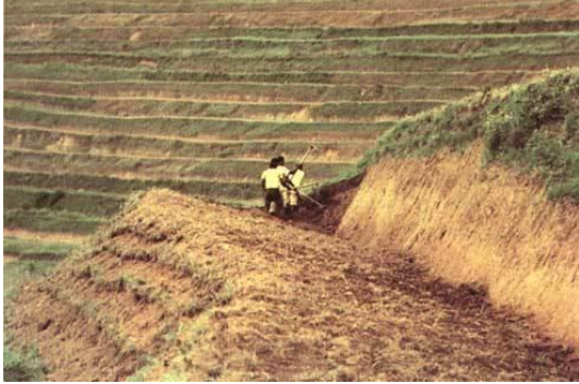
Figure 41 : Travaux de construction des terrasses radicales (Rwanda)
