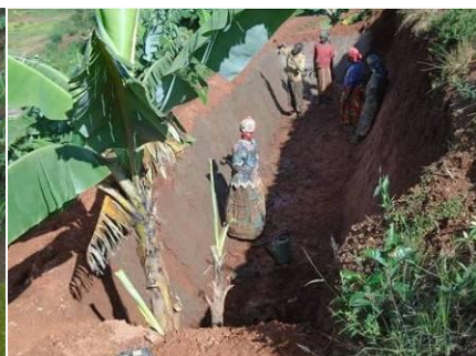
Figure 100 : Vue d'un fossé de rétention d'eau avec murs renforcés avec l'argile (source : ISABU)
