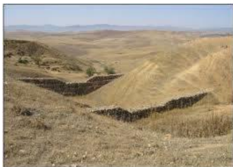
Figure 48 : Série de seuils en maçonnerie (source : physio-geo.revues.org )
