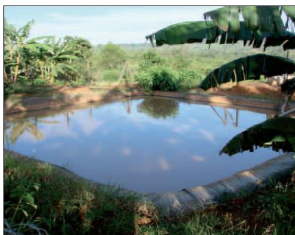
Figure 98 : collecte et stockage de l'eau dans un petit bassin, au Rwanda (Malesu Maimbo)
