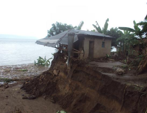
Figure 72 : Les pluies torrentielles et glissements de terrain (photo réalisée par Cyrille HICINTUKA)
