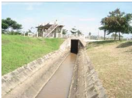
Figure 103 : Vue du canal principal (zone irriguée de Rukaramu) (source : FAO)
