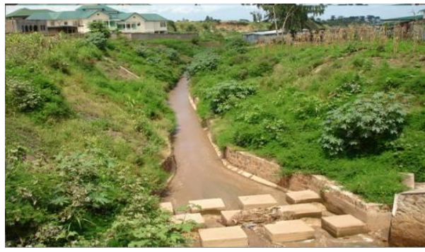
Figure 54 : Rives redimensionnées et des ouvrages de dissipation sur la rivière Gihosha (photo réalisée par Cyrille HICINTUKA)
