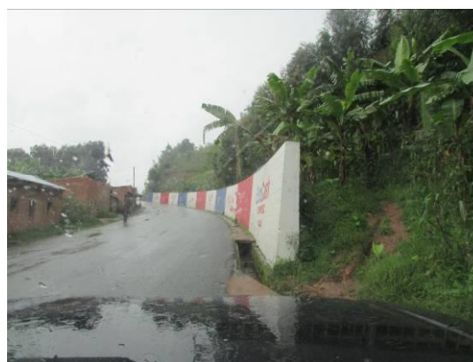
Figure 56 : Mur de soutènement construit sur la route Bujumbura-Bugarama (photo réalisée par Cyrille HICINTUKA)
