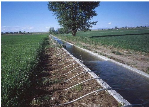
Figure 113 : Système d'irrigation par sillons utilisant des tubes en siphon
