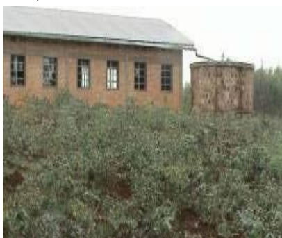
Figure 97 : Collecte des eaux pluviales pour la consommation familiale (Gasorwe, Muyinga) (source : FAO)
