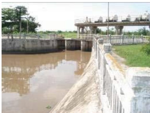
Figure 101 : Vue générale de barrage de diversion sur la rivière Mpanda (zone Rukaramu) (source : FAO)
