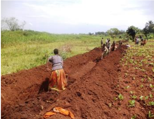
Figure 73 : Creusement d'un canal de démarcation de la limite entre la zone tampon et les champs des riverains du lac (source : LVEMPII)
