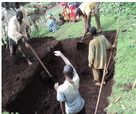
Figure 90 : Creusement d'un silo-fosse
