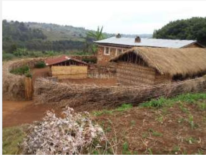
Photos: Usage d' Arundinalia alpina dans la construction
