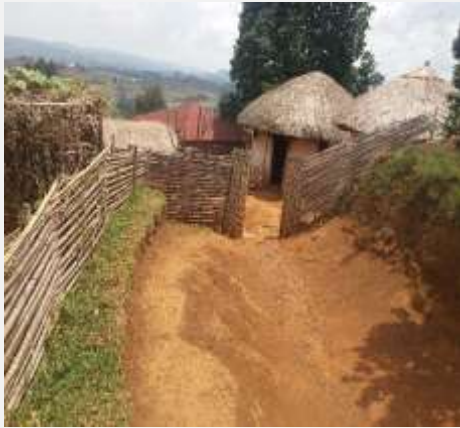
Photos: Usage d' Arundinalia alpina dans la construction
