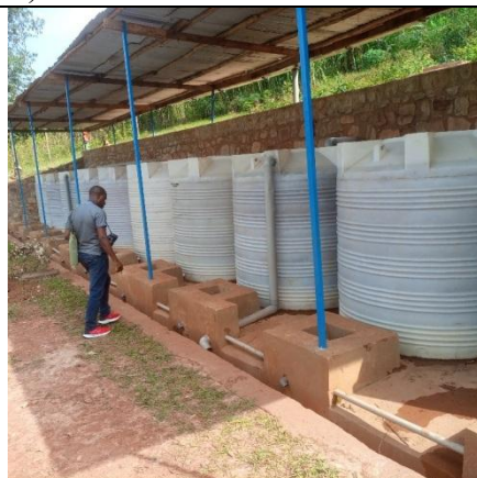
Figure 23: Installation pour irrigation collinaire en commune Isare, colline Bibare, sous-colline Ruyange, par collecte des eaux de ruissellement
