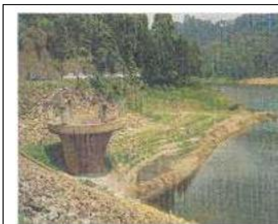
Figure 16: Niveau du lac de retenue de la CHE de Rwegura en 2008. Source : TCNCC
