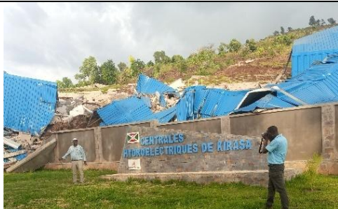
Figure 18: Destruction totale de nouvelles installations de la Centrale Hydroélectrique de Kirasa suite aux glissements de terrain (Avril 2024)
