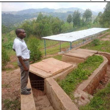
Figure 23: Installation pour irrigation collinaire en commune Isare, colline Bibare, sous-colline Ruyange, par collecte des eaux de ruissellement
