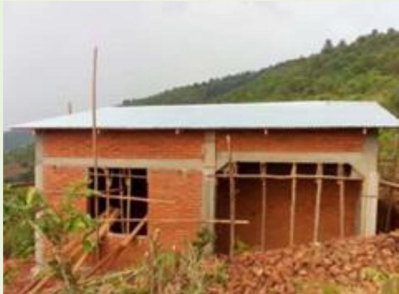
La photo ci-dessus est le nouveau poste de surveillance en cours de construction
